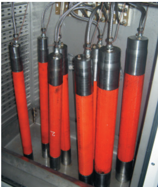
Рис. 2. Образцы труб ИЗОПРОФЛЕКС в термошкафу
